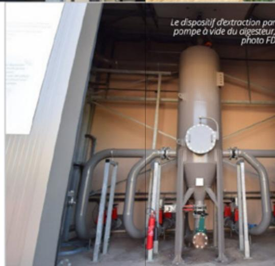
Le dispositif d'extraction par pompe à vide du digesteur, photo FD
